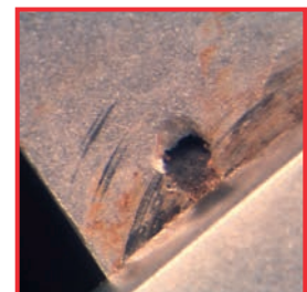
Beispiel für Lochkorrosion
